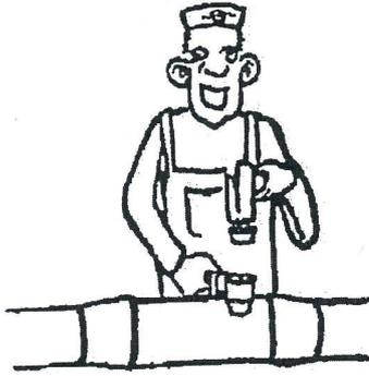
Nach dem Aushärten des Schaums (ca. 60 Minuten) die Entlüftungsstopfen mittels Reißglasche entfernen. Schaumloch auf 24mm aufbohren (Pex Mediumrohre nicht anbohren) und den Expansionsstopfen einschlagen. Danach den mitgelieferten Keilstopfen einbringen.
