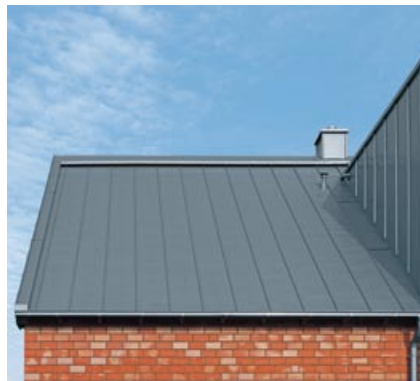
Stehfalzdeckung mit schmaler Giebelabdeckung und Lüfterfirst
