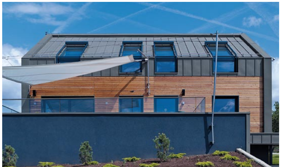
Stehfalzdeckung Dach/Fassade und Giebelabdeckung
